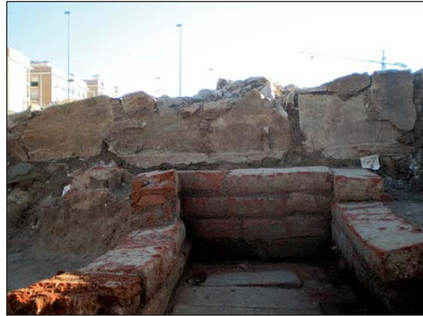
FIGURA 18 Detalle encintado muro S de A 5 y A 23.
