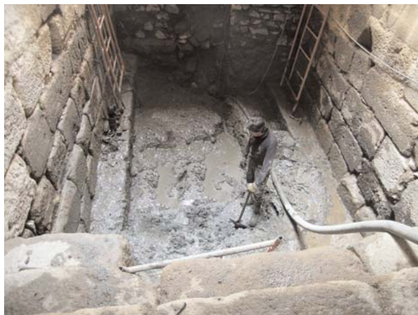
FIGURA 4 Excavación de la cisterna.
