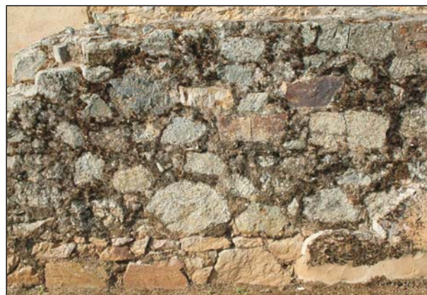
LÁMINA 13 Detalle de la técnica constructiva.
