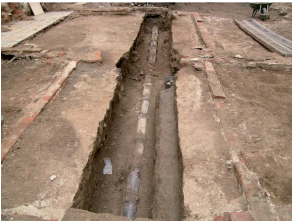
FIGURA 5 Zanja y tubería ue 31.
